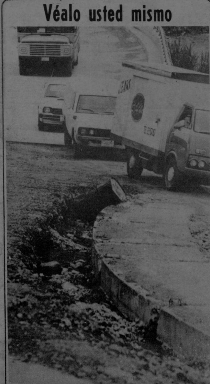
El nuevo puente de los Incurables, cerca del Asilo Carlos María Ulloa, carretera a Guadalupe, está unos días en servicio y otros no. Como se aprecia en la gráfica no es muy seguro transitar por el ya que las lluvias han lavado el material dejando zanjas peligrosas. (Castillo)
